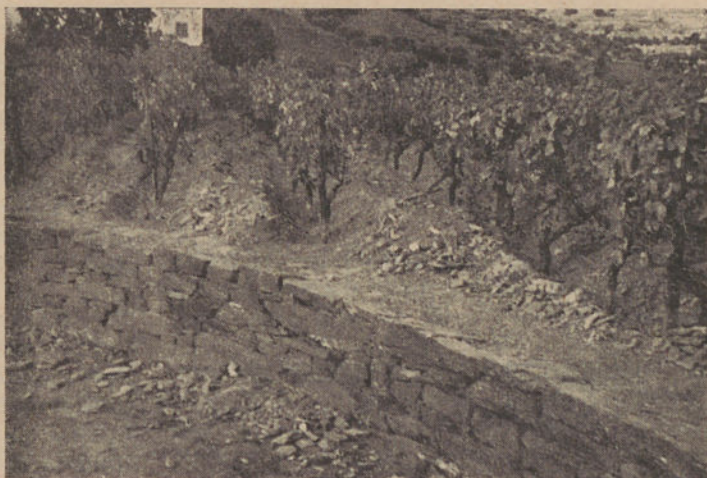
Escava de rota aberta
