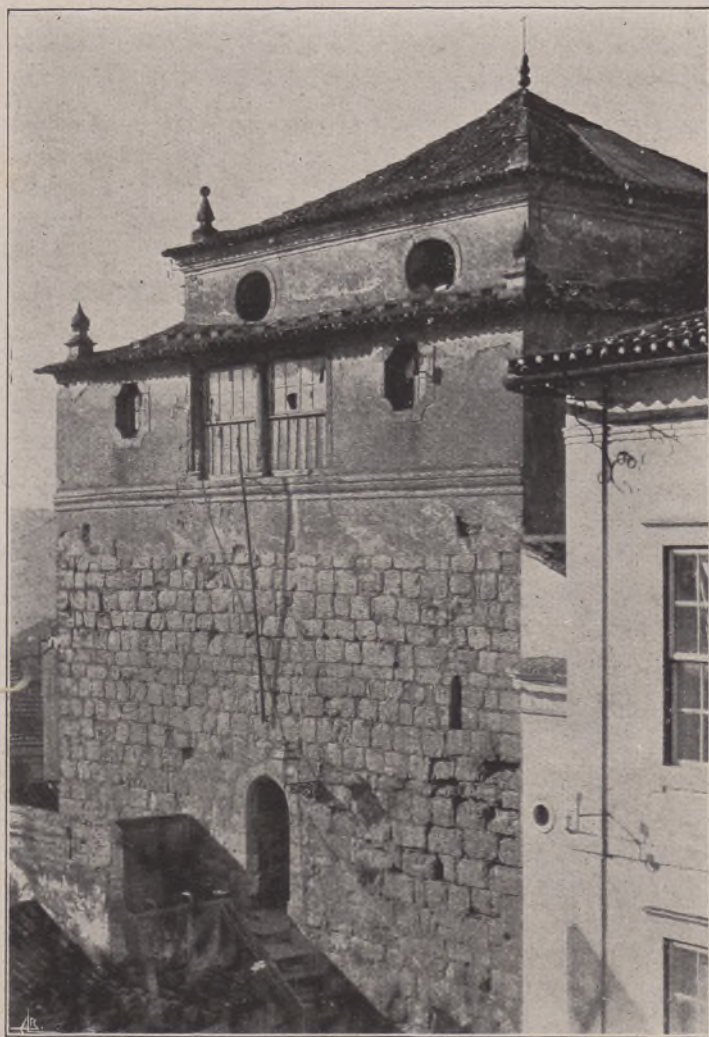
Edifício onde está instalada a Escola Livre das Artes do Desenho
