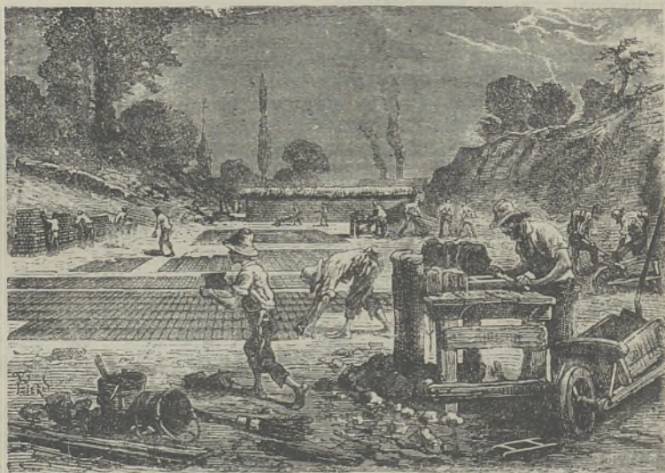
Fig. 34—Fabrico manual de tijolo
