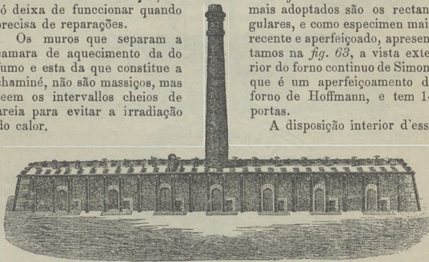
Fig. 63 — Vista exterior d'um forno continuo rectangular
