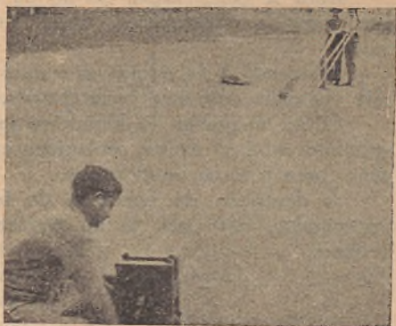
Fig. 28 — Reünindo os cabos
