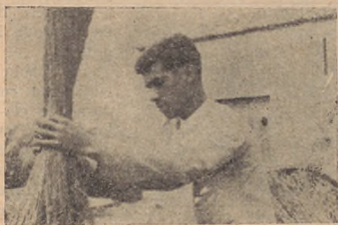
Fig. 10 — Maçando o linho; 1. a fase
