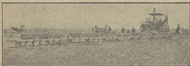
Fig. 187 — Lavoura e sementeira a vapor, sistema americano
