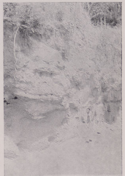
Fig. 6 — Couraça brechóide muito espessa sobre rocha basáltica, no nível de 80-100 m, observada no Roça Palmar
