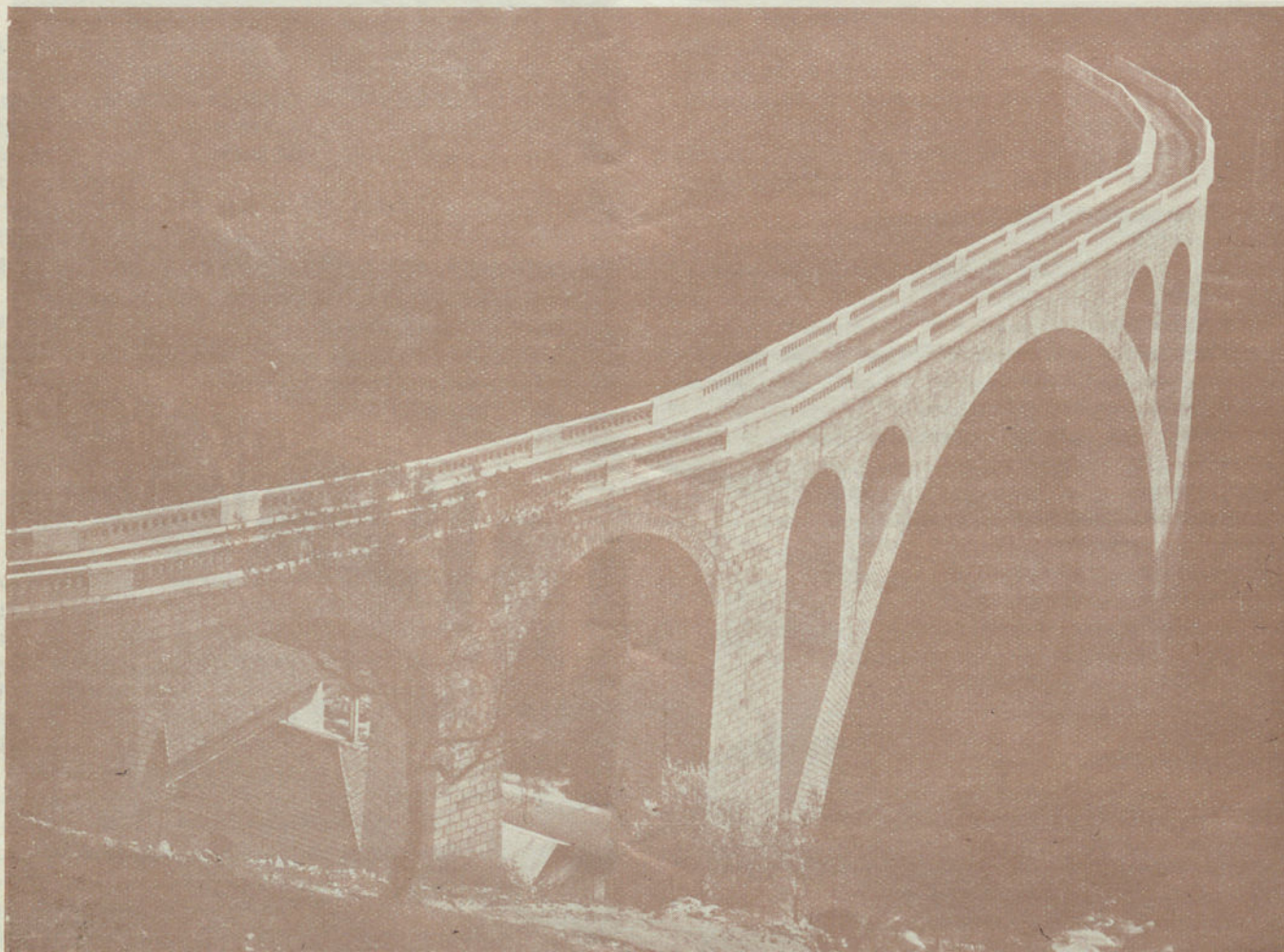
PONTE DO VAROSA, QUE SE NOTABILIZA PELO FACTO DE SER CONCLUIDA EM CURVA E DE UM SÓ ARCO ABRANGER AS DUAS MARGENS DO RIO
