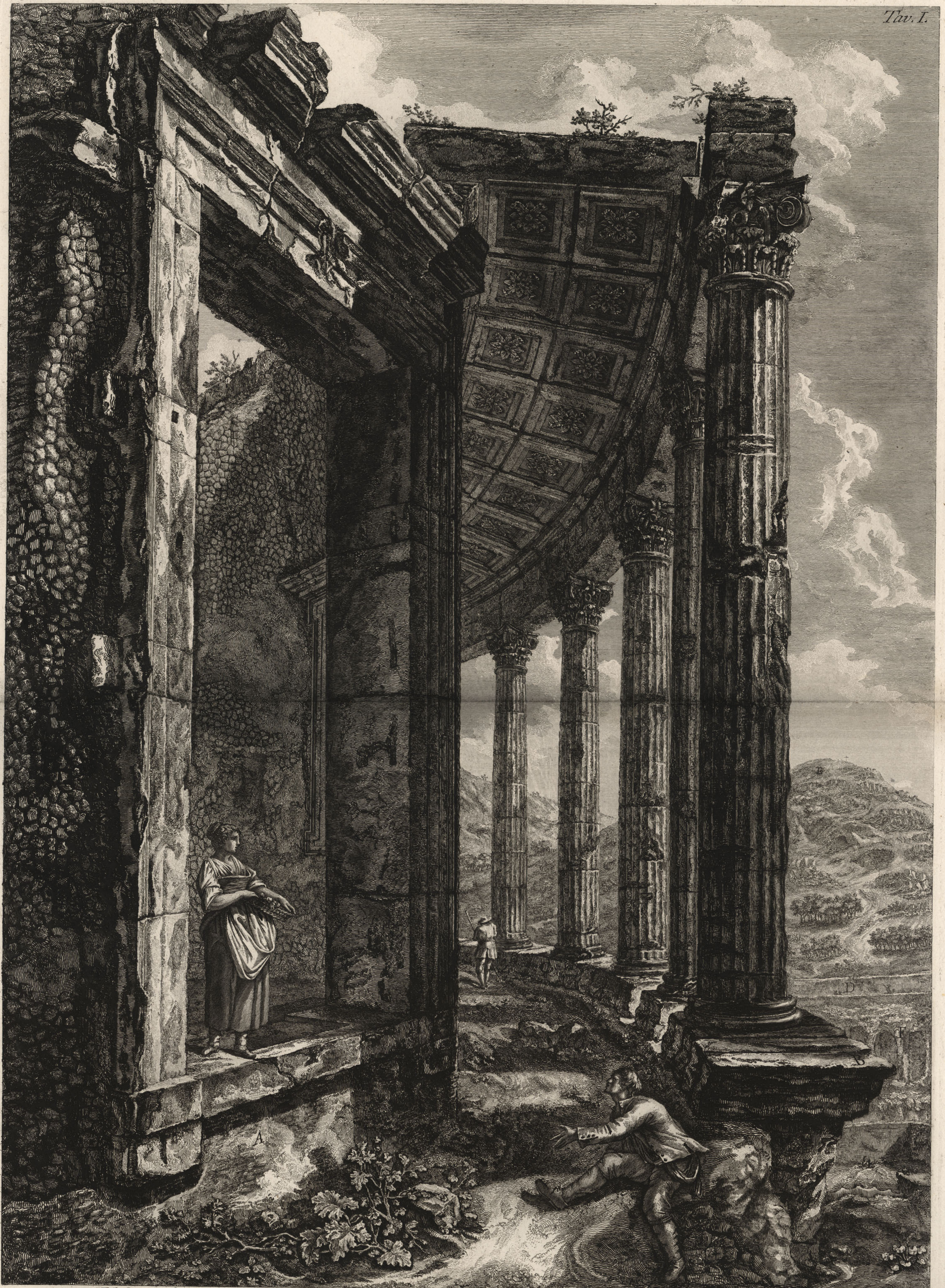
Veduta della porta e peristilio del Tempio di Vesta detto volgarm. della Sibilla in Tivoli A. Riparazione moderna nell'incasso de' gradi della porta, fatta d'ordine di N. S. Papa Pio VI. B. Cimasa del basamento interrotta da gradi del tribunale, o scala, che ascende- va al piano del peristilio. C. Incasso del Litostrato, o pavimento di marmo. D. Strada di Quintiliano, che guida alle Cascatelle. E. Monte Catillo. F. Sustruzioni antiche, le quali investono il Monte
