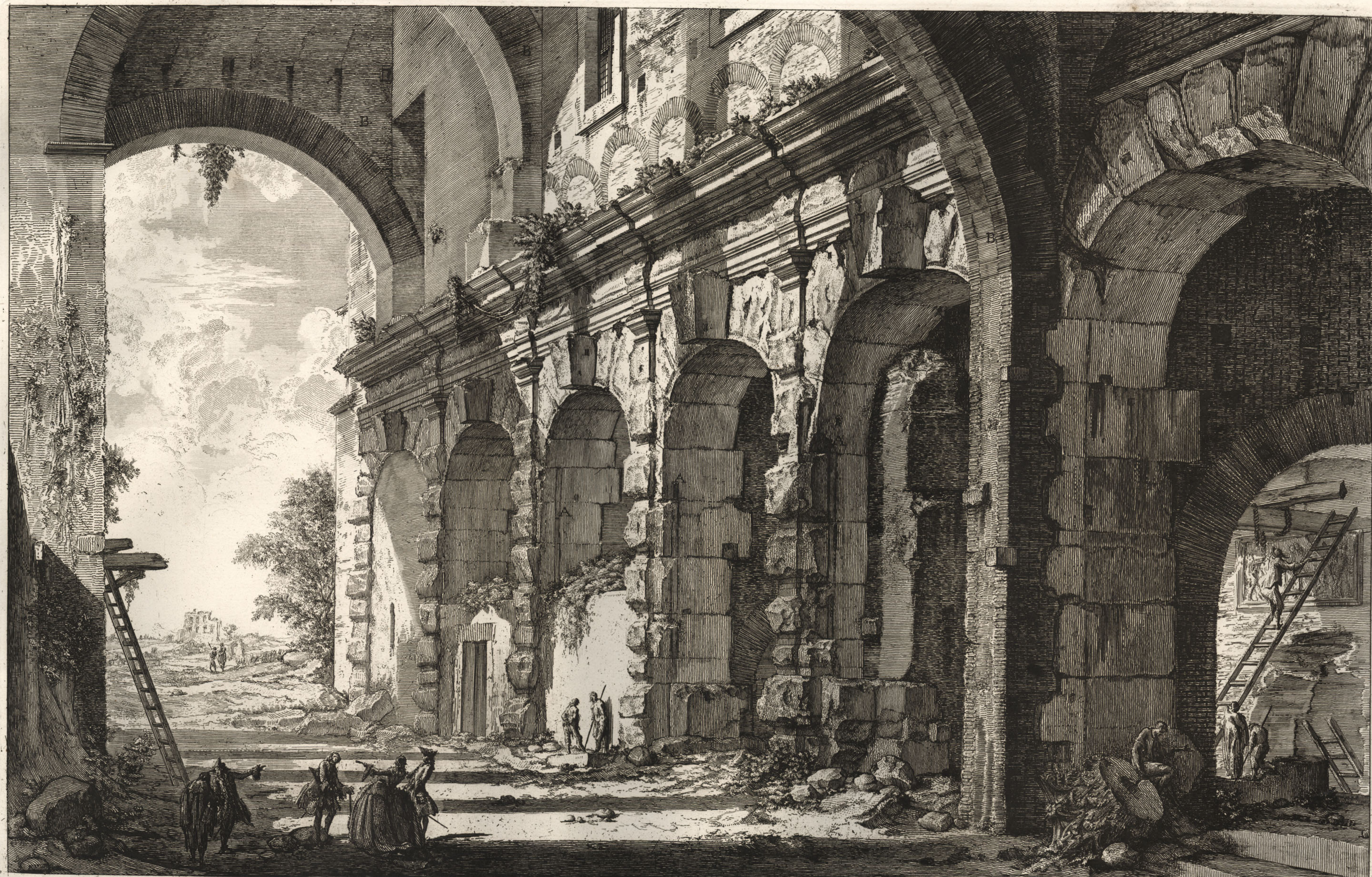
VEDUTA DEL PIANO SUPERIORE DEL SERRAGLIO DELLE FIERE FABBRICATO DA DOMIZIANO A USO DELL' ANFITEATRO FLAVIO, E VOLGARMENTE DETTO LA CURIA OSTILIA Tiranesi Architetto fecit. Il primo piano di questa gran fabbrica rimane interrato nelle rovine, che inoggi uguagliano il piano di Roma, e dagli scavi fatti, si è trovato parimente composto di grossi macigni di travertino. A. Segni, ove si appoggiavano i muri di tavolozza che serravano gli archi. B. Muri de' tempi bassi. Sopra di questi Archi è fabbricato il Campanile e Convento de' Padri della Alleanza di SS. Giovanni, e Paolo. Presso l'autore a Strada Felice vicino alla Trinità de' monti.
