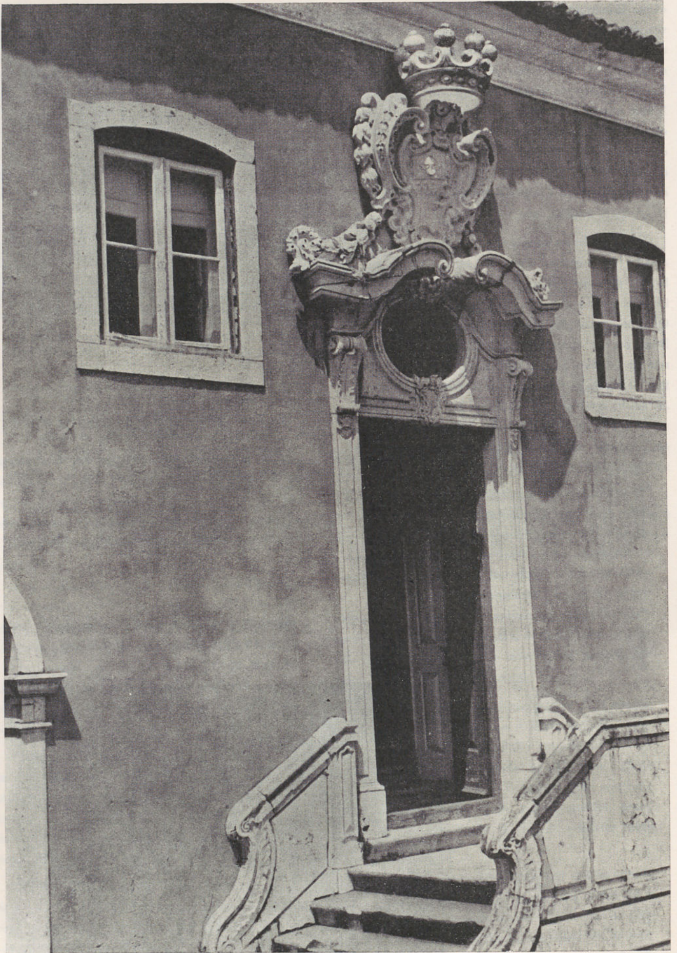
«Casa Pintéus» — Portal principal da casa.
