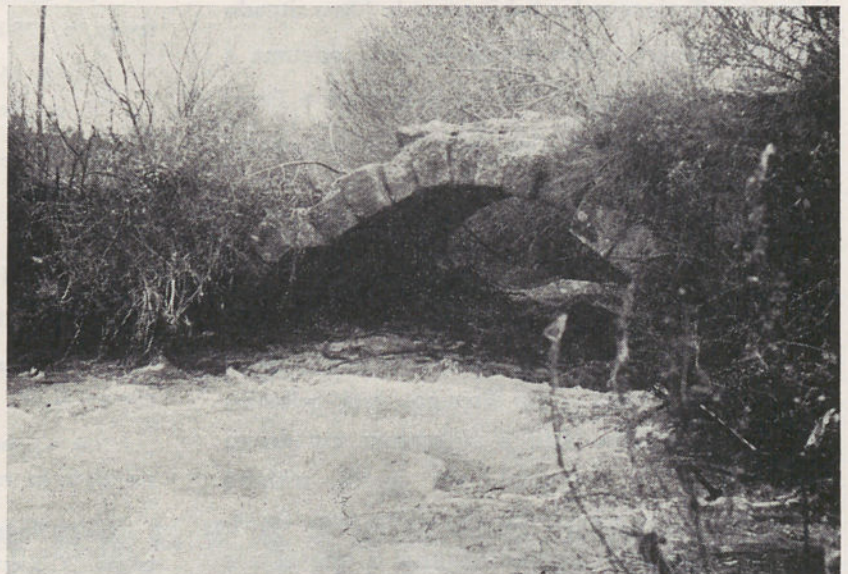
Arco da ponte romana da Bemposta, sobre a ribeira das Taliscas. (Dezembro de 1979).
