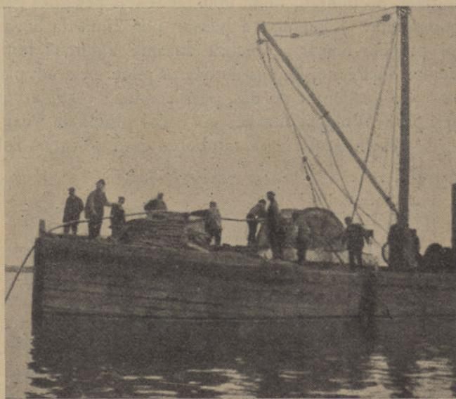
Fig. 5 — O cabo desenrola-se sôbre a roldana do pontão rebocado e caí no leito do rio
