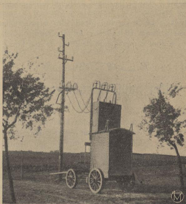
Fig. 4—Posto de ligação de alta tensão com uma estação de transformadores transportável, ligada
