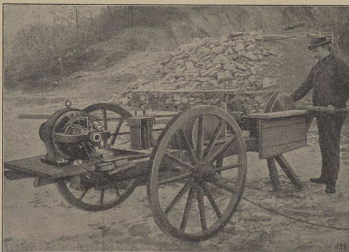
Fig. 11 — Motor de corrente contínua, transportável, accionando uma serpa circular
