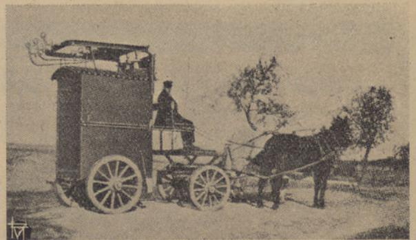
Fig. 3—Estação de transformadores transportável para o serviço duma máquina de malhar
