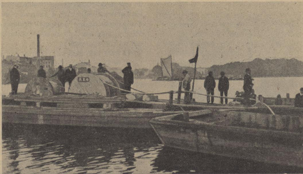
Fig. 6 — A colocação de 2 cabos de corrente contínua e dum condutor neutro através do Dahme, perto de Coepenick
