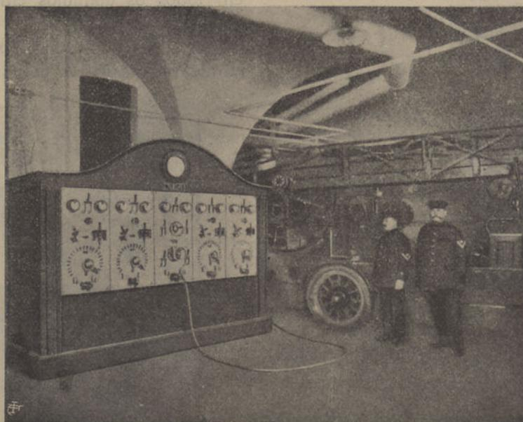
Fig. 4 — Convertidor carregando uma bateria de carro-escadas Magirus
