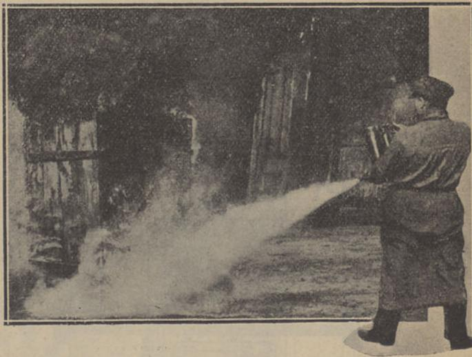
Fig. 2 — Fazendo uma experiência com o extintor sobre barracas de madeira incendiadas
