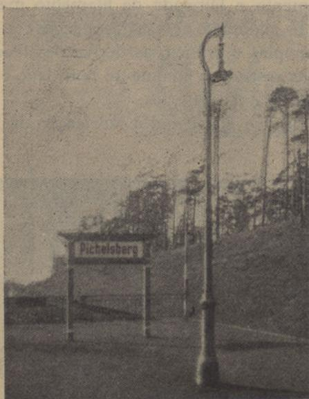
Fig. 4—Poste de ferro para a iluminação da gare de Pichelsberg
