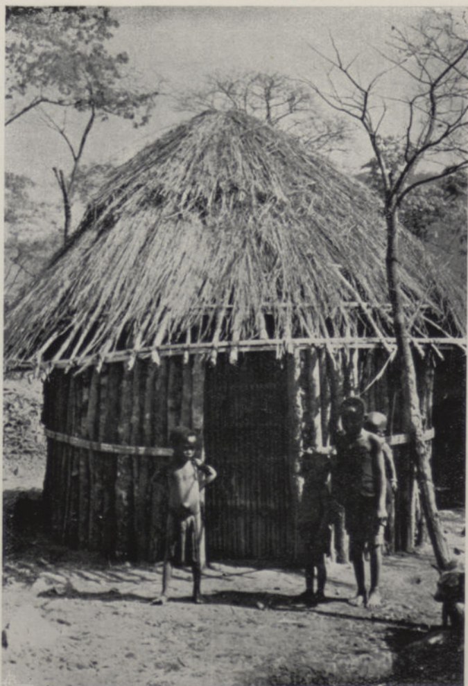
Fig. 78 — Palhota ( nhumba ) de Coêra com insuficiente cobertura de capim, deixando ver os paus da armação. A porta é feita de hastes de bambu rachadas a meio. As paredes da palhota mostram os paus desnudos, sem a camada de barro justaposto que se encontra noutras regiões e que é conhecida pelo nome de matique . Esta palhota não tem licole (v. fig. 68).
