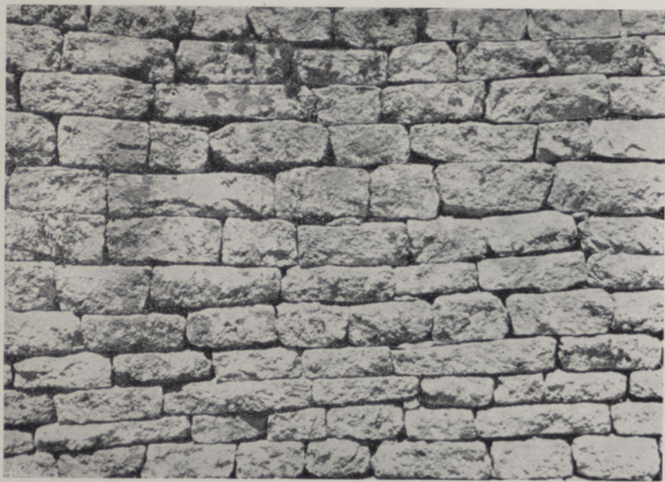
Fig. 25 — Pormenor da muralha do templo elítico de Zimbaué, para mostrar a sua construção feita com pedras de secção rectangular sem interposição de qualquer cimento ou argamassa. A êste tipo architectónico pode bem chamar-se opus rectangularis .
