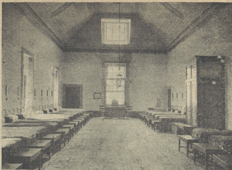
Uma enfermaria do Hospital thermal, no 1.º andar, na esquina N. E do edificio, tal como estava em 1890, com o aspecto do sec. XVIII.
