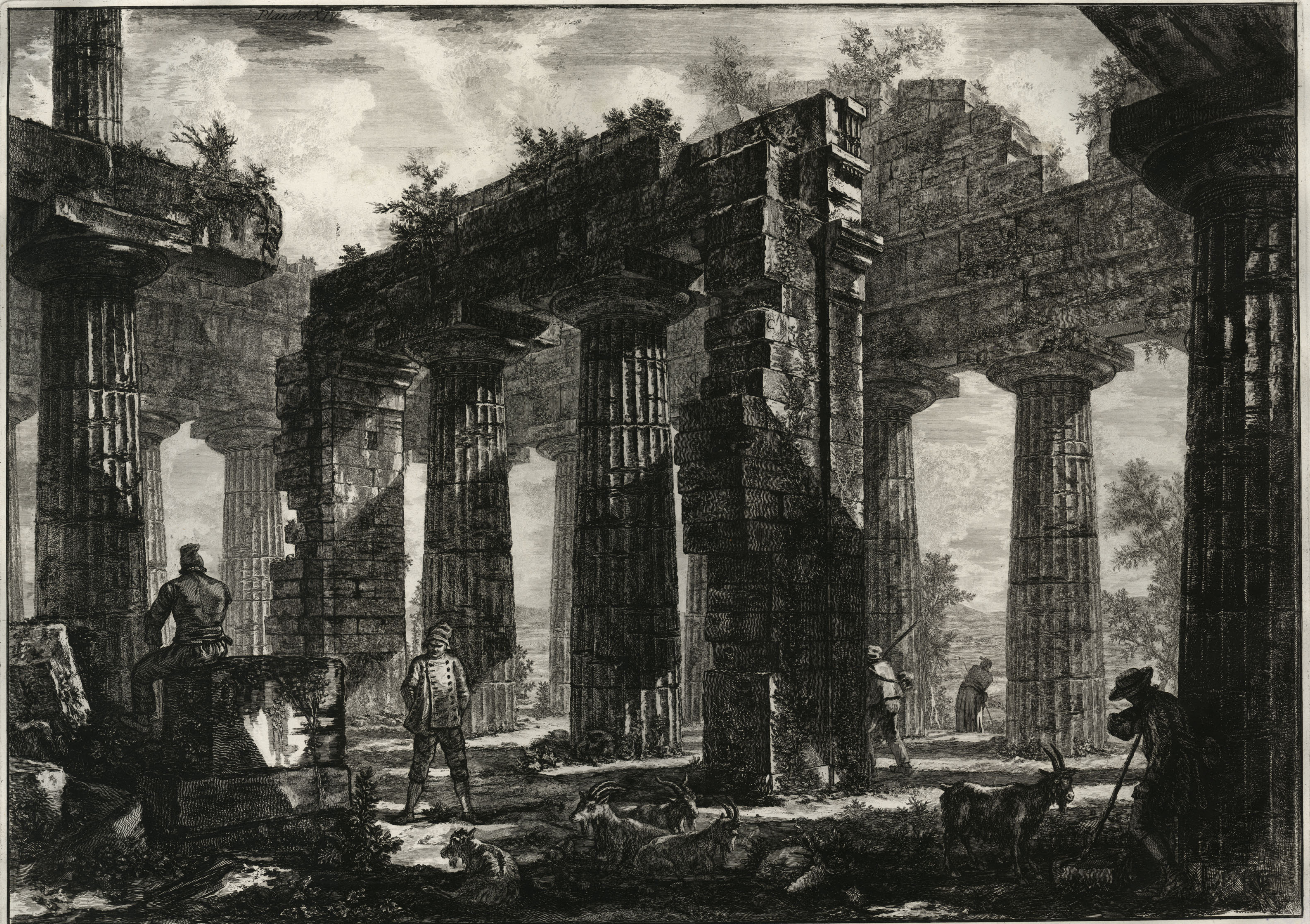
Vue des restes du derrière du Pronaos du Temple de Neptune dessinée dans les deux planches précédentes. A Pilastre rendu d'une proportion plus élégante que celui B. L'on trouve à côté d'eux, les restes C des murs internes de la Celle. D Restes de deux rangs de Colonnes qui étoient situés dans la Celle du Temple. Cav. Piranesi F.
